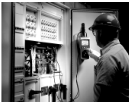
图4-4. 在将新的系统连接到市电之前，技术人员利用兆欧表测试了电缆引入线和开关装置。
