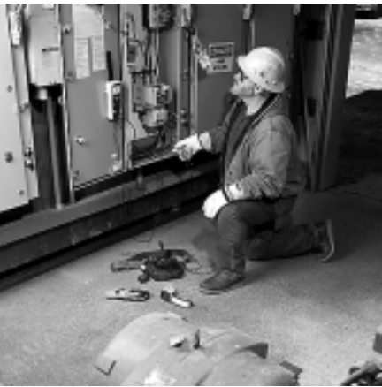
绝缘多用表用来检查电气开关和相关设备上绝缘的完整性。
