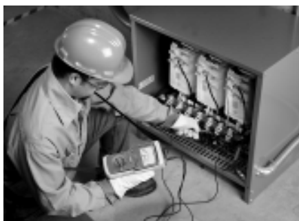
图4-1. 当安装了新的设备或维修过的设备时，安装者要在安装之后，系统投入运行之前进行测试。
